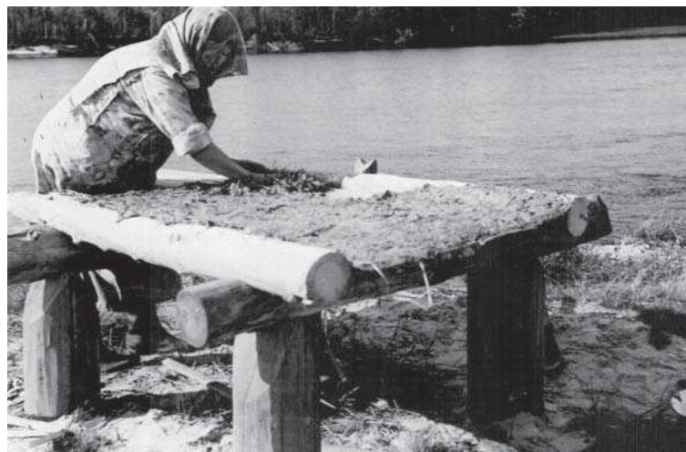
Рис. 112. Заполнение глиной дна хлебной печи (юрты Усановы)
