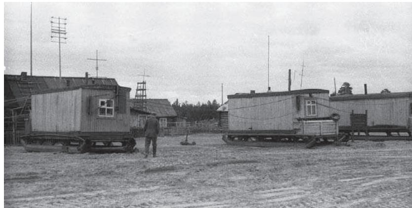
Рис. 298. Передвижное жилище нефтяников – балки (дер. Юильск)
